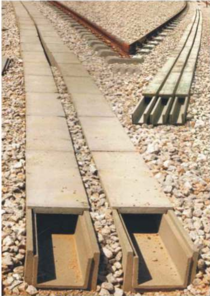
ΚΑΝΑΛΙ K160 & K90 ΤΟΠΟΘΕΤΗΜΕΝΟ ΣΤΟ ΑΤΤΙΚΟ ΜΕΤΡΟ
